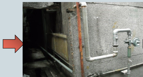
民生管線臨遷 (瓦斯、自來水)
