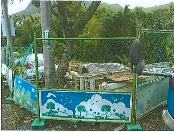
1. 工程材料堆置，宜距離喬木樹幹1-1.5公尺以上，減少根系因工程材料重壓而無法有效吸收水分致使植栽生長不佳。
