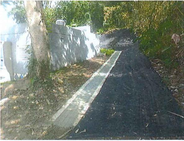
1. 羅浮污水處理設施後方邊坡，雖已鋪設防塵網防止揚塵與邊坡沖刷，仍建議補植植栽穩固鋪面。
