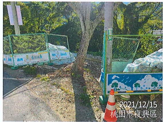
1. 工程材料堆置，已派員整理，並距離喬木樹幹約1公尺以上，不因重壓而可以有效吸收水分致使植栽生長佳。
