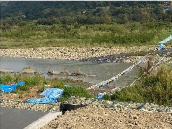
4. 跨橋鋼索有用浮筒暫時放置於河道上，浮筒間皆有空隙讓水流通過，施工段水質顏色正常，無前次現勘混濁之情事。
