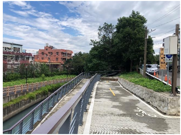
110/11/12/車道東側入口
