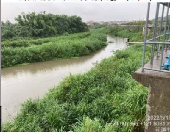
新生橋下游國強抽水站往下游拍攝 (111/05/19)
