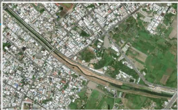
東昌橋下游低水灘地現況
