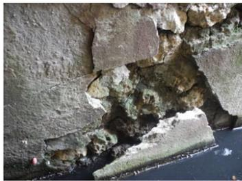
圖 A：全臺首學大樓後方水泥溝體壁面剝落，裸露下方硃砧石
