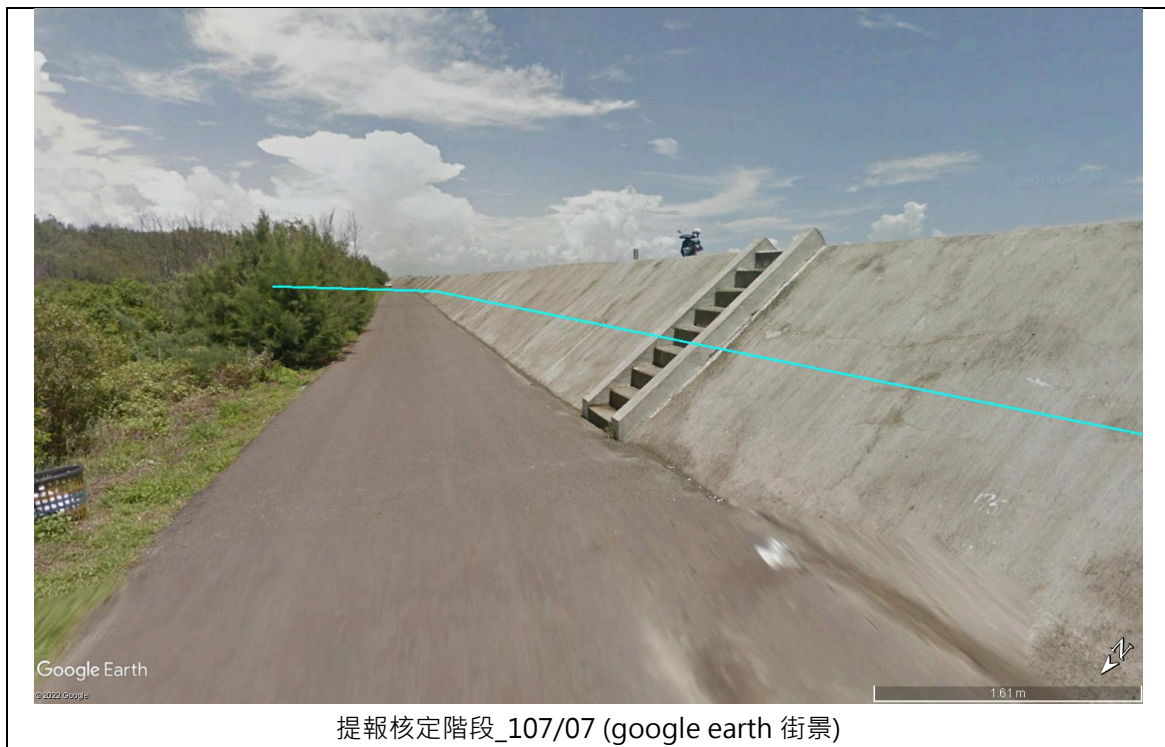
圖 2 「青草崙堤防濱海景觀休憩廊道營造計畫」提報核定階段影像紀錄
