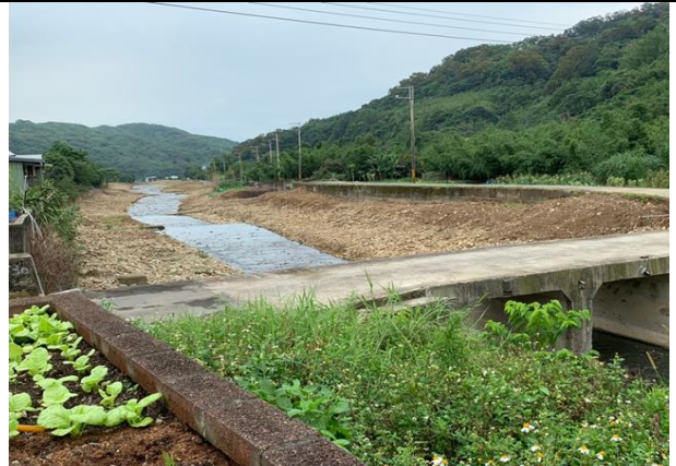
1.便橋下游(河道整理後)
