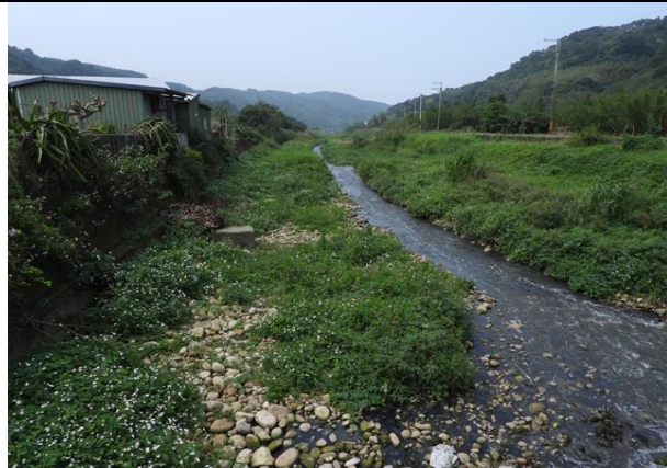
1.便橋下游(河道整理前)
