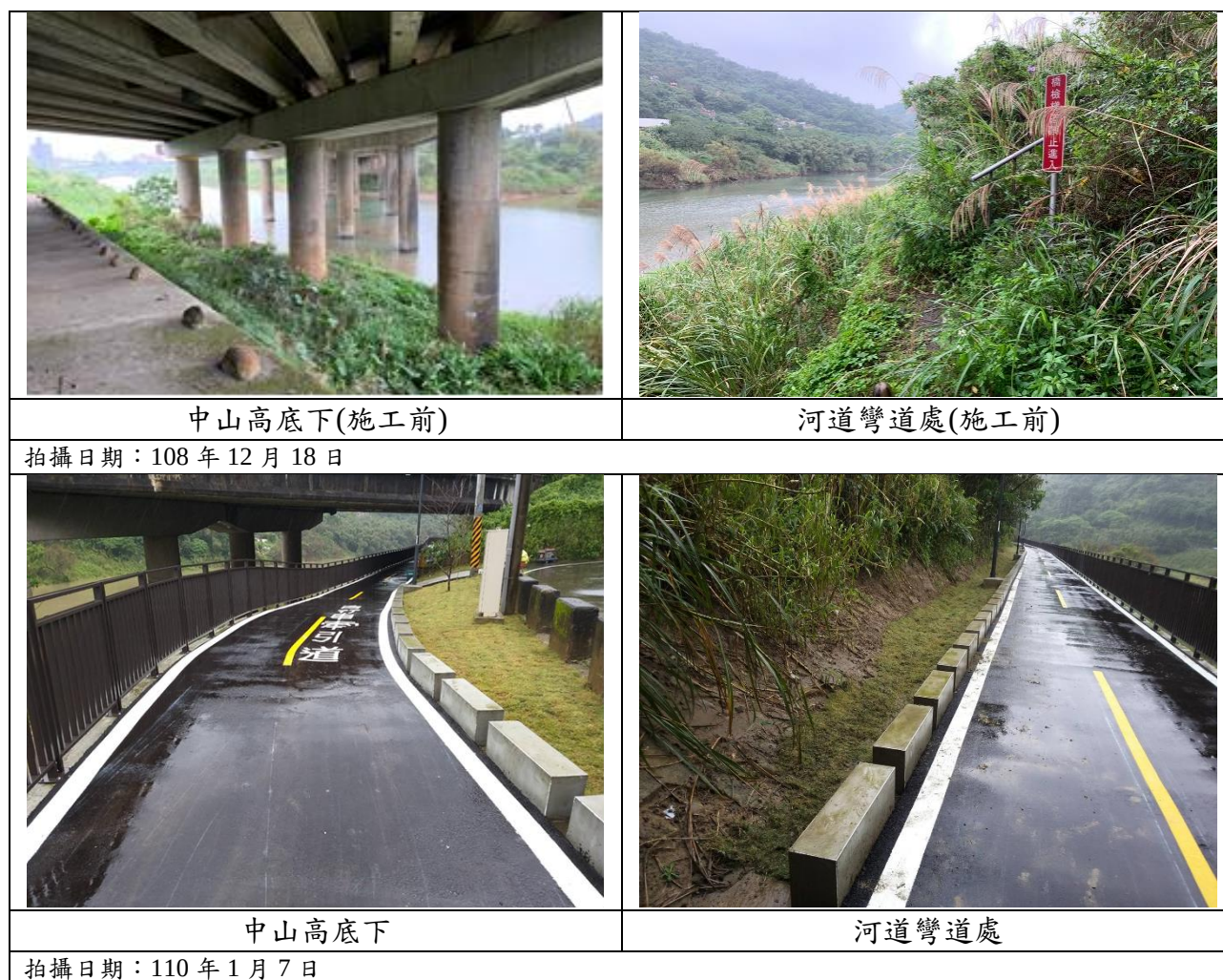
圖 2-1 五堵貨場高速公路橋上游休憩廊道串聯施工前後照片
