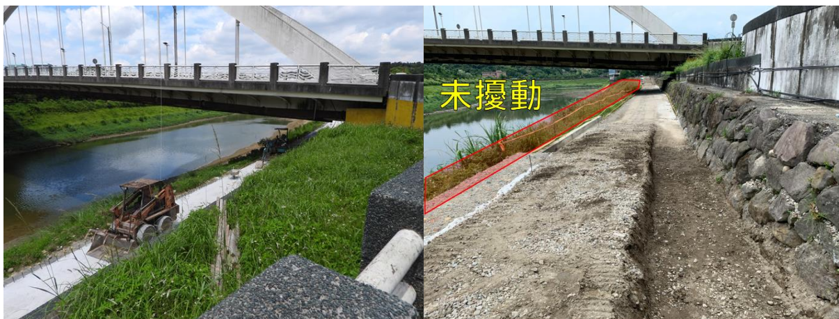
圖 3-7 最小擾動施工
