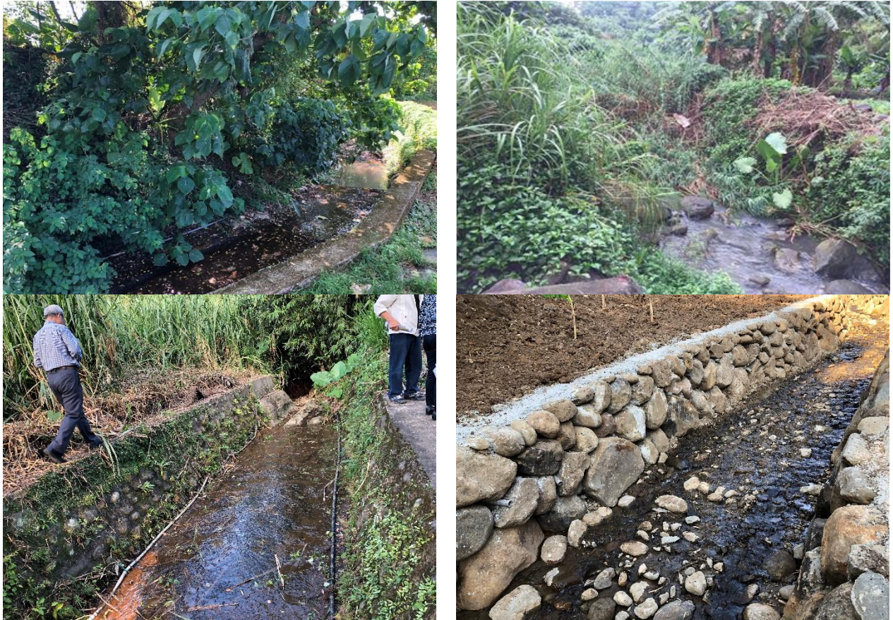
圖 6-2 淡水區民生里樹梅坑 19 號旁排水改善工程環境現況圖
