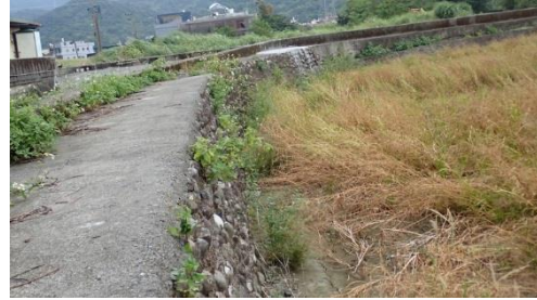
左岸護岸近農田側為砌石，可供兩棲爬蟲及蝦蟹類上岸
