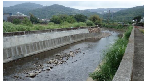
左岸護岸部分有溝槽，植物自然長出
