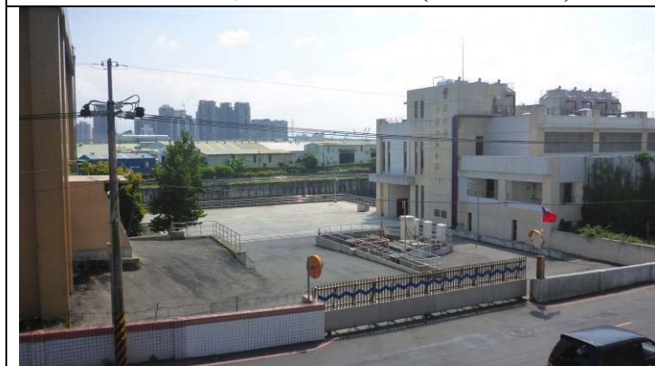
環境照-鄰近區之中港抽水站
