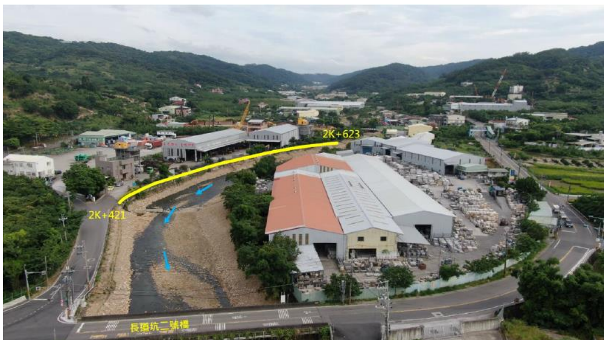
圖 4-1 「水仙溪長道坑二號橋至 2 號無名橋間護岸改善應急工程」工程範圍
