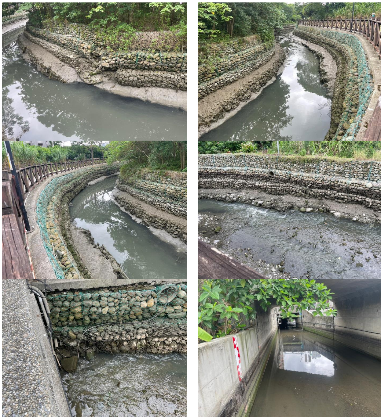
圖 5-4 「淡水區樹梅坑溪出河口段石籠修復工程」現況照片
