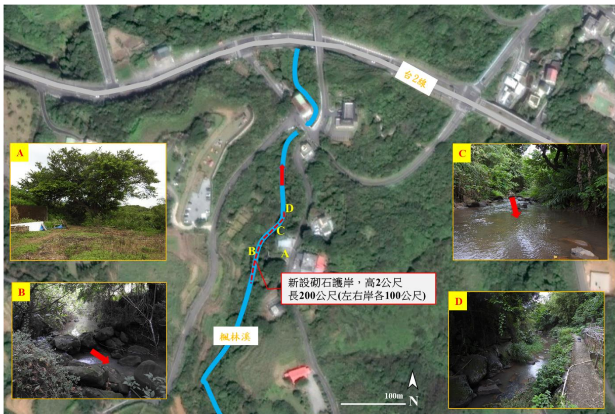
圖 4-1 「石門區楓林溪護岸新建工程」工區預計施作範圍及環境現況圖
