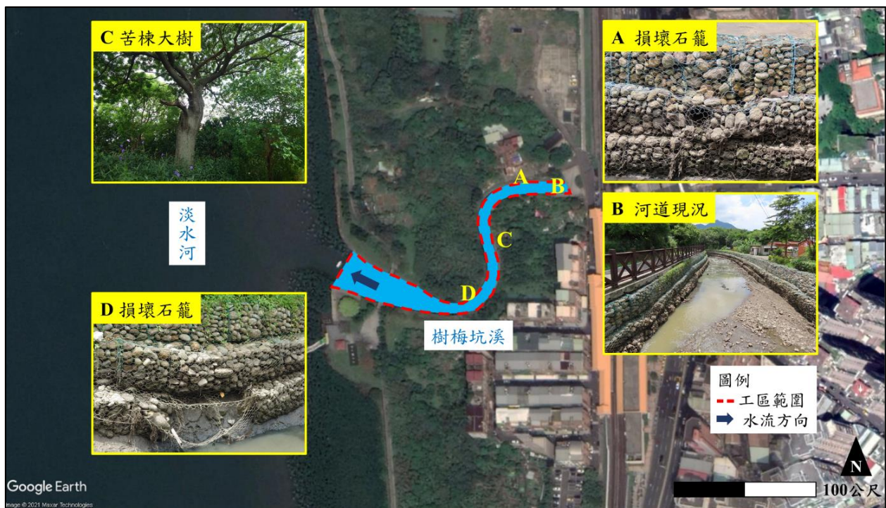
圖 5-1 「淡水區樹梅坑溪出河口段石籠修復工程」工區預計施作範圍及環境現況圖
