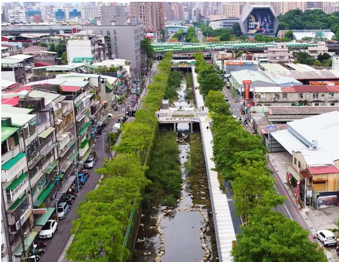
圖 15 藤寮坑溝第 1 期工程完工成果空拍圖
