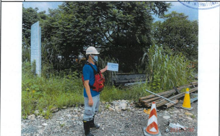
照片2 說明 盡量避免砍伐既有樹木。 日期：110年7月30日 督察單位：林同棧工程顧問股份有限公司 新店碧潭堰監造工務所 安倉營造股份有限公司/三源興股份有限公司
