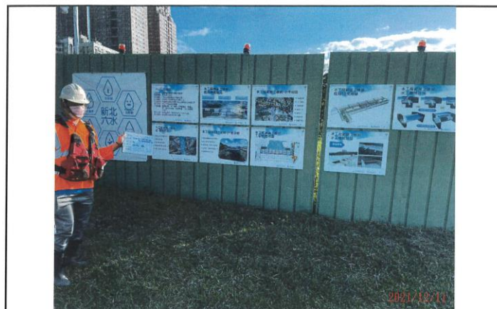
照片1 說明：工程告示及生態維護願景告示牌12片。 日期：110年12月11日 督察單位：林同棧工程顧問股份有限公司 新店碧潭堰監造工務所 安倉營造股份有限公司/三源興股份有限公司
