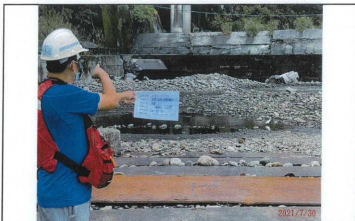
照片1 說明 保育原有生物生態環境。 日期：110年7月30日 督察單位：林同棧工程顧問股份有限公司 新店碧潭堰監造工務所 安倉營造股份有限公司/三源興股份有限公司
