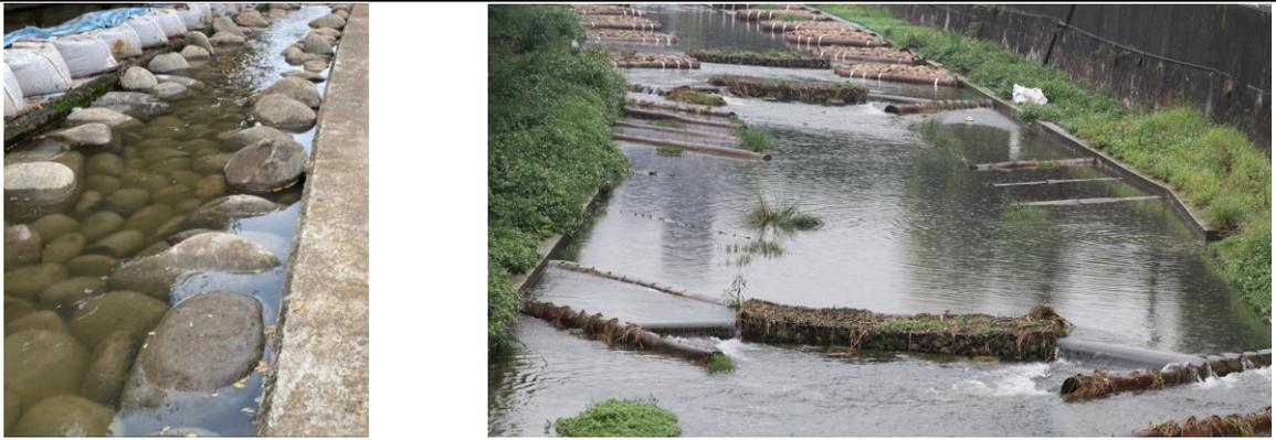
圖 5-2 卵塊石、石籠固床工成果示意圖
