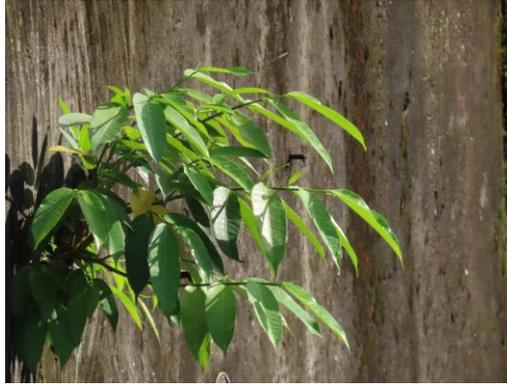
(圖為生長於渠道內牆上的雀榕，長大後根部易造成結構危害。)
