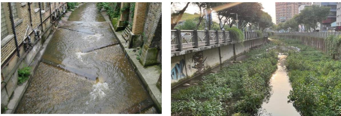
圖 5-4 擾流工及生態通道示意圖
