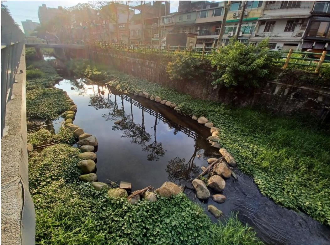
圖 5-7 藤寮坑溝兩側堤牆缺乏植生現況照
