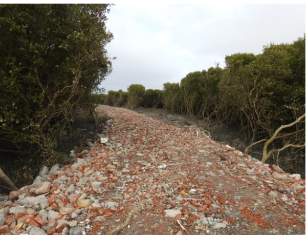
圖 8、臨時性施工便道，是以營建廢棄物作為底鋪材料
