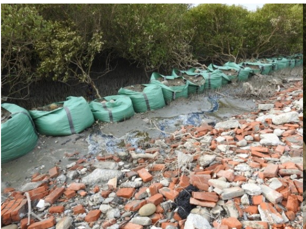
圖 8、臨時性施工便道，是以營建廢棄物作為底鋪材料
