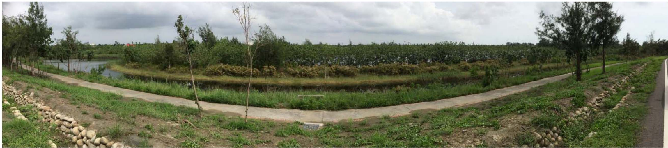
北池-北側現況(漿砌卵石溝-邊坡-戲台-水面-陸連島植生)
