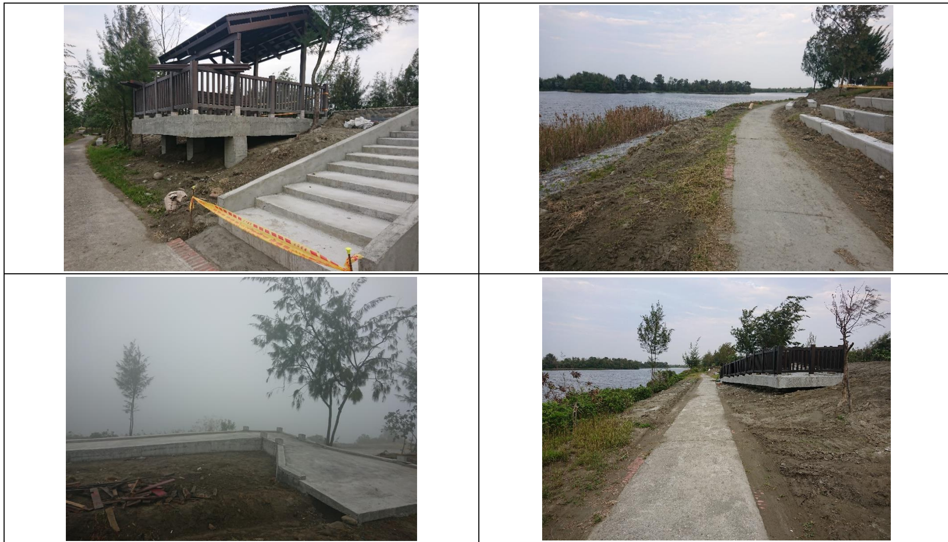
照片 3(續)、工程設施照片
