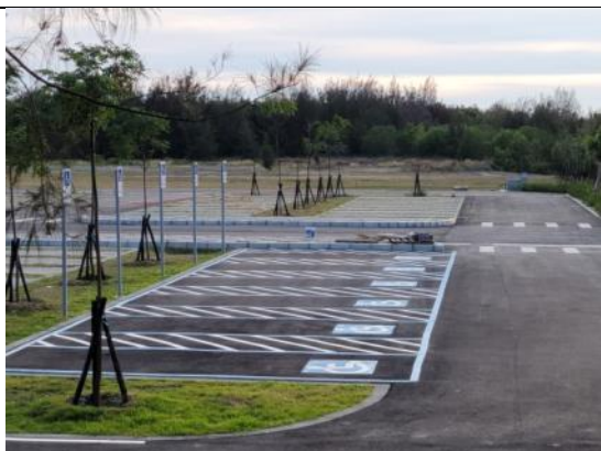
基地內施工完成現況 (2021 年 5 月 13 日拍攝)
