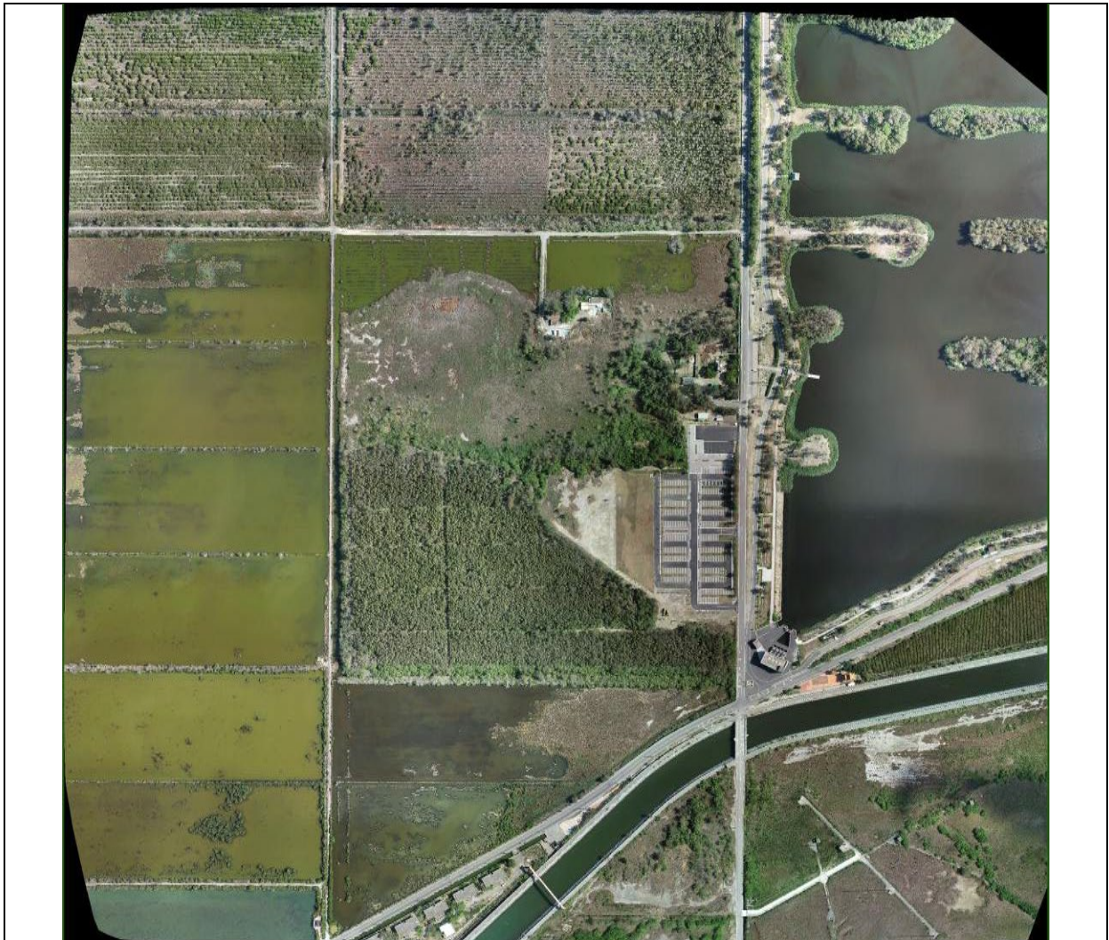
施工後現地低空航照正射圖(陞多公司拍攝，拍攝日期：2021/5/12)
