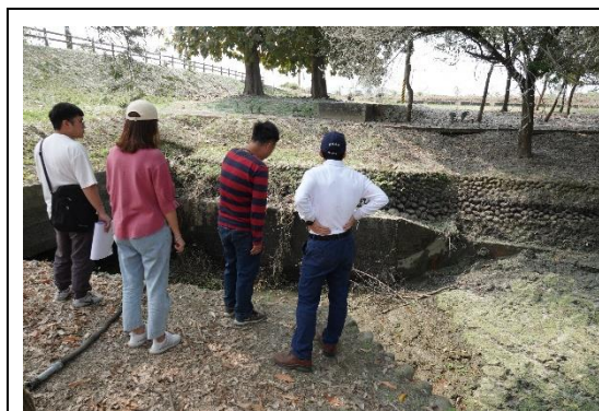
圖 4.2-1：現勘沈澱池抽水後狀況
