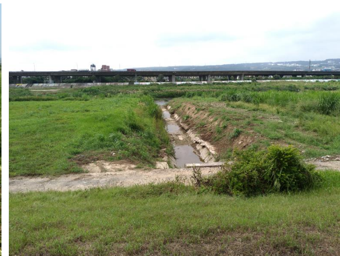
右岸區排匯入灘地渠道狀況
