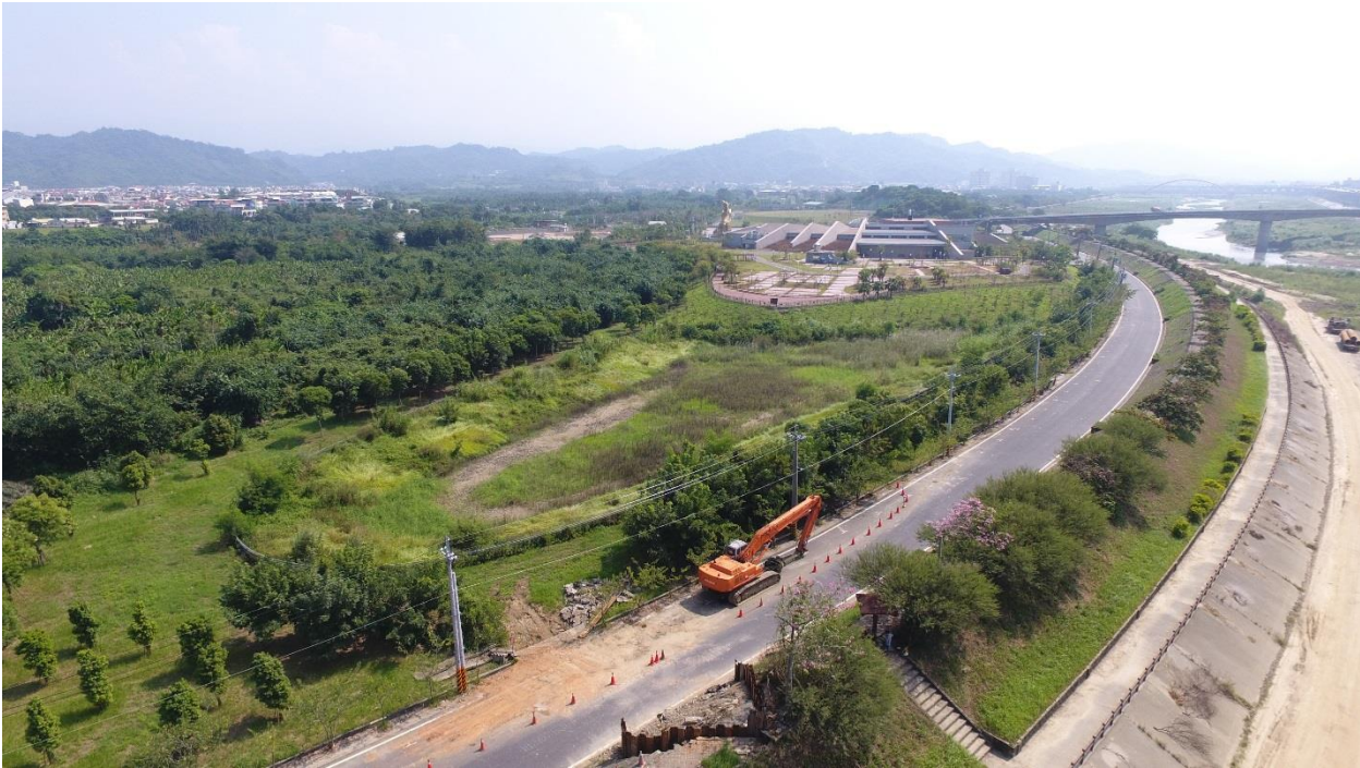
第一批次工程基地空拍照片
