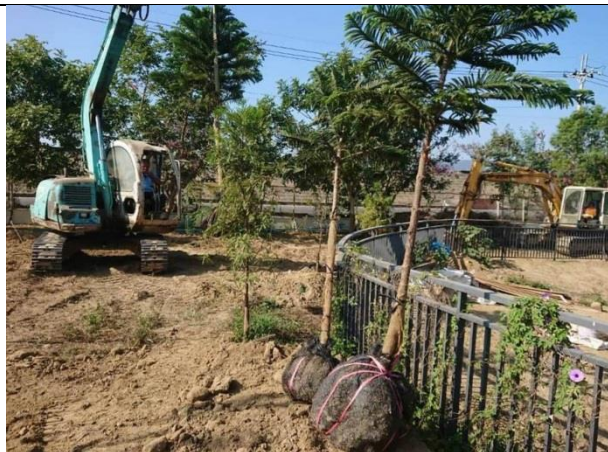
107/11/15 施工中移植喬木種植照片
