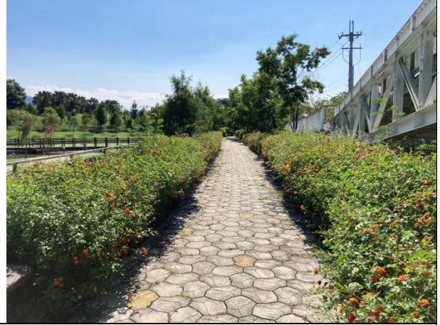
110/10/25 完工後滯洪池周邊步道照片
