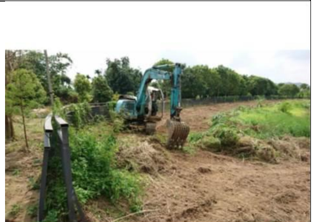
107/9/12 施工中滯洪池清理照片
