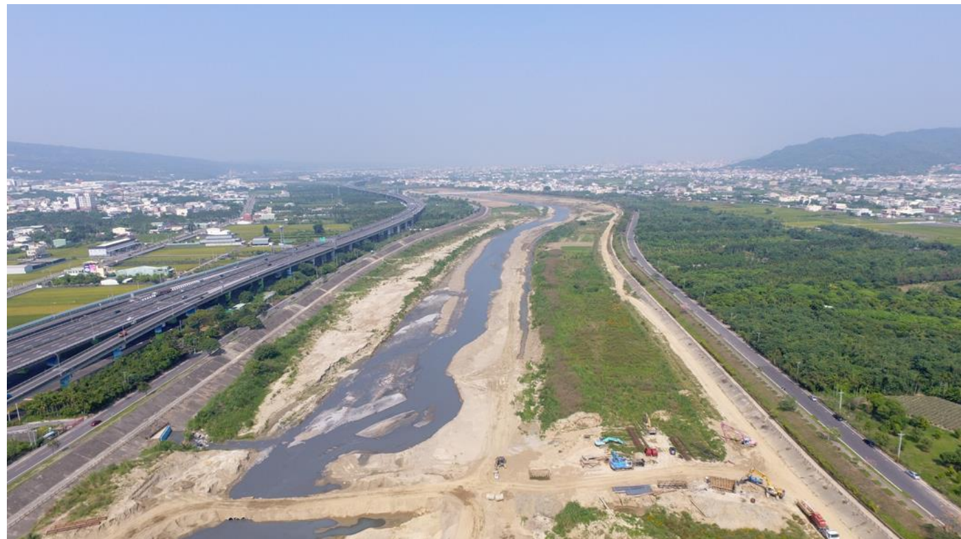
貓羅溪河道整理工程空拍照片(中游段祖師橋以北)
