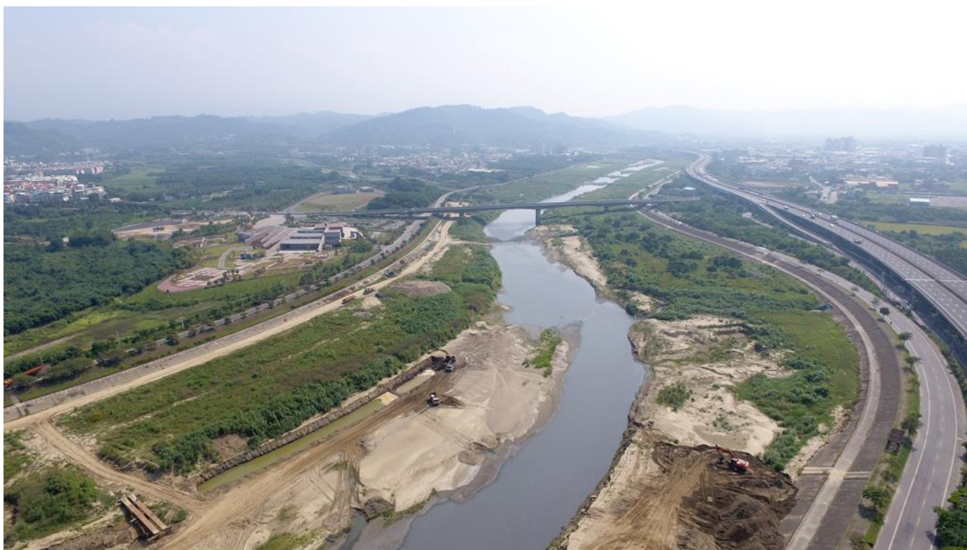
貓羅溪河道整理工程空拍照片(中游段會展中心旁河灘地)
