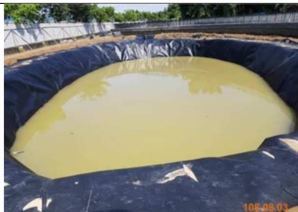
108/8/3 施工中礫間池照片
