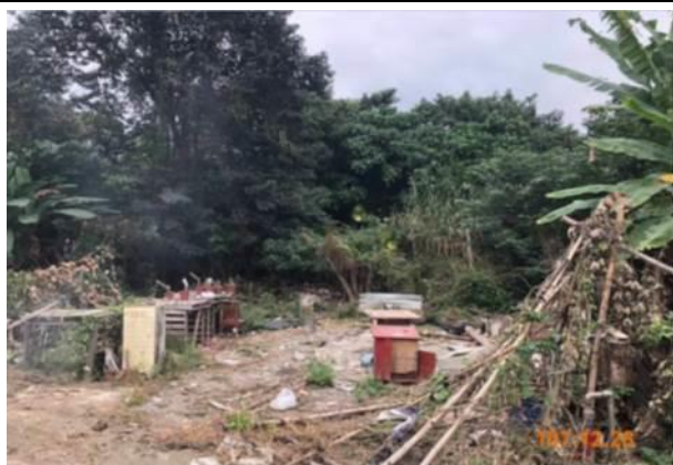
107/12/28 施工前氧化塘照片
