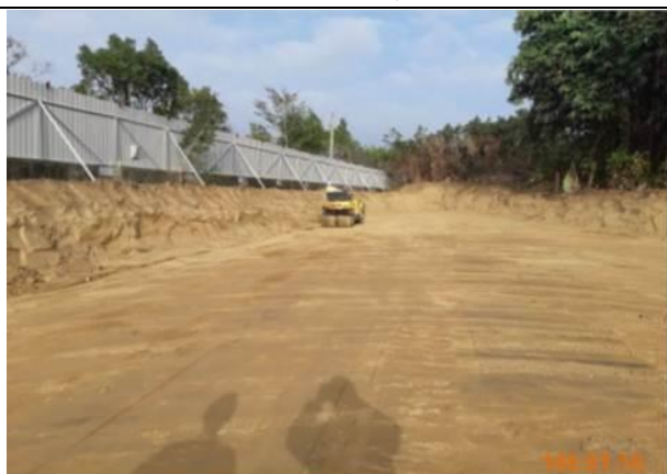
108/1/18 施工中氧化塘照片
