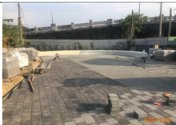
108/11/2 施工中廣場照片
