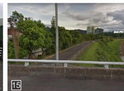
13.14. 江北二橋與下游堤頂防汛道路交接處未有車阻設施，導致鄰近住戶將車輛停放佔用堤頂自行車道空間，現有道路寬度約為6m，可銜接至下游高速公路橋側。
