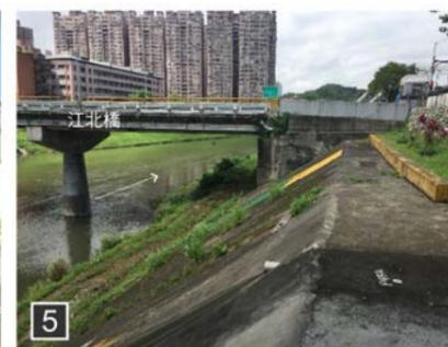
4. 汐止聯絡道橋底距堤頂約2m高，現有堤頂寬度約4m。
