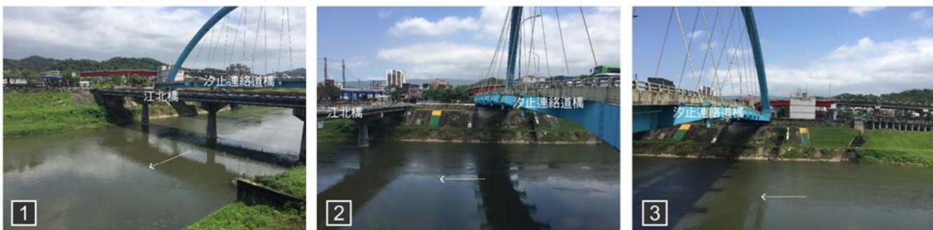
1.2.3. 江北橋至汐止聯絡道橋下空間現況，江北橋與汐止聯絡道橋距約23m，汐止聯絡道橋上游約4公尺處有排水口、約35公尺處有排水閘門口，上游現有自行車道因排水閘門，自行車道以抬升方式經過水閘門，後續銜接有困難。
