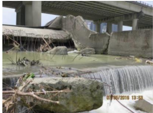
二號橡皮壩右側溢流堰明顯損壞
