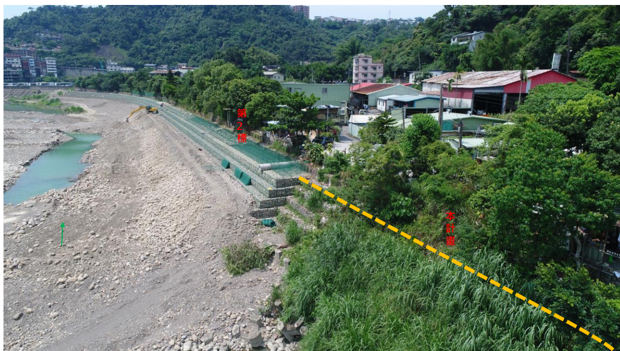
圖 2.2 碧潭壩上游至烏來沿線亮點營造工程(第 2 標延伸段)
