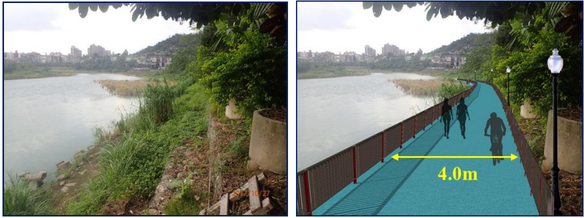
圖 2.3 碧潭堰上游至烏來沿線亮點營造工程(第 2 標延伸段)
