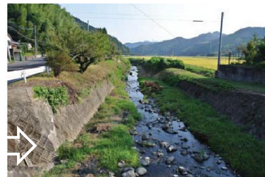
雖是混凝土護岸但寬深比適當及深槽保留低水路自然蜿蜒
