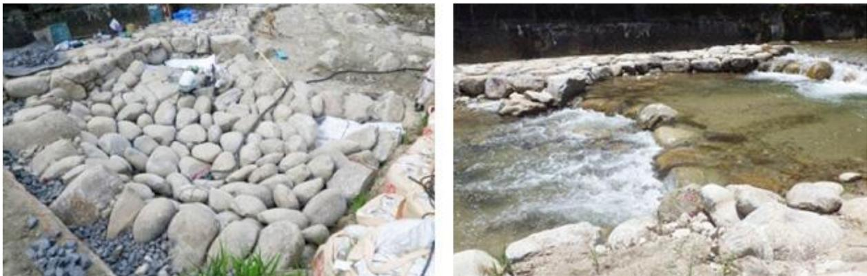
圖 23 全斷面砌石拱型固床工施工中及完工後照片
