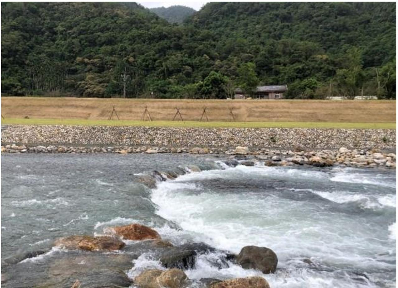
圖 42 砌石拱型固床工完工示意圖
