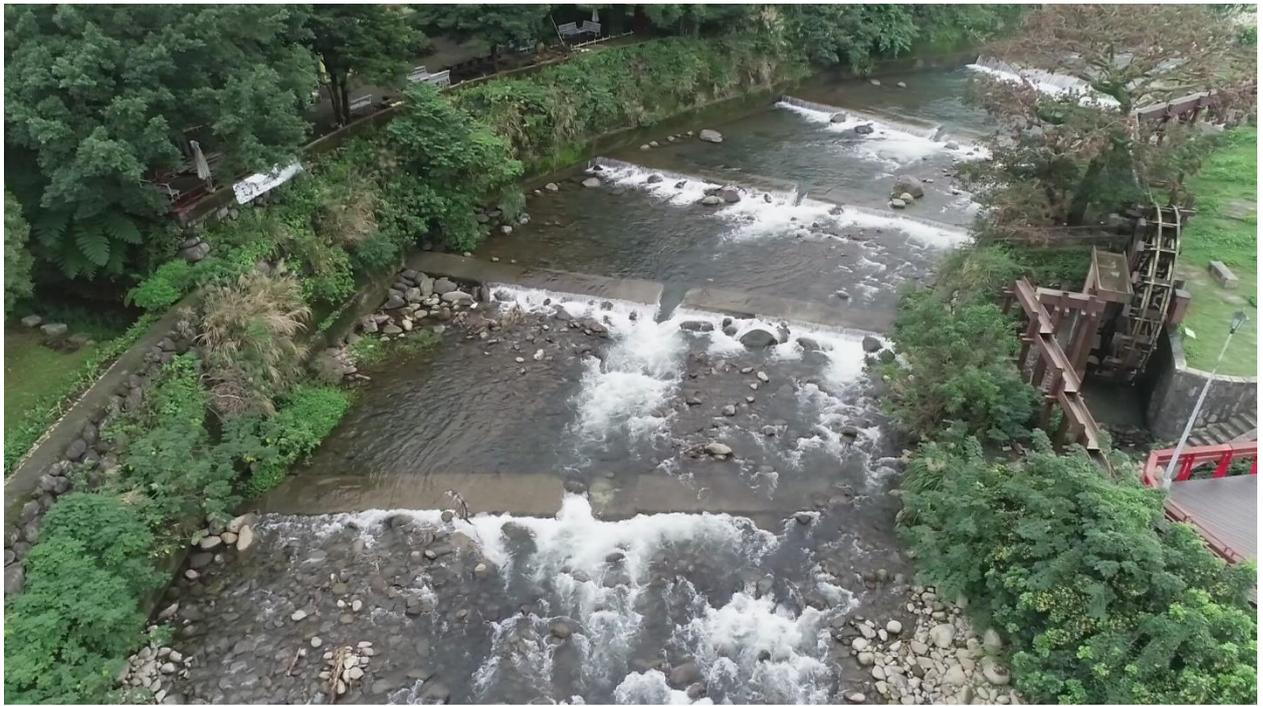
圖 41 破除平壩面製造缺口示意圖
