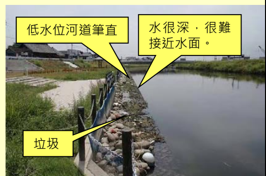
⑦ 左岸側水際線砌石環境
