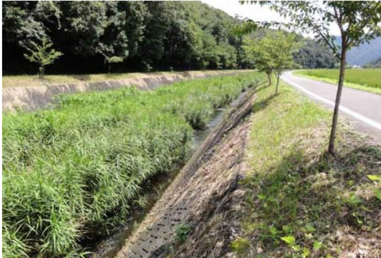
圖 5-12 拓寬河寬導致降低推移力的失敗案例
