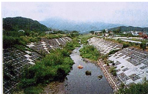
圖 5-29 利用河川擺動的力量引導低水路水際域的案例
