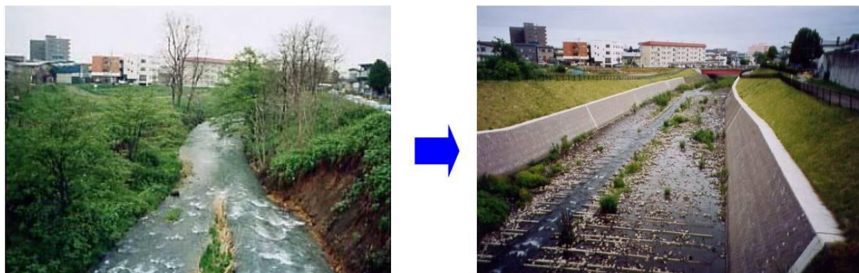
圖 5-27 整治後粗糙度降低的案例
