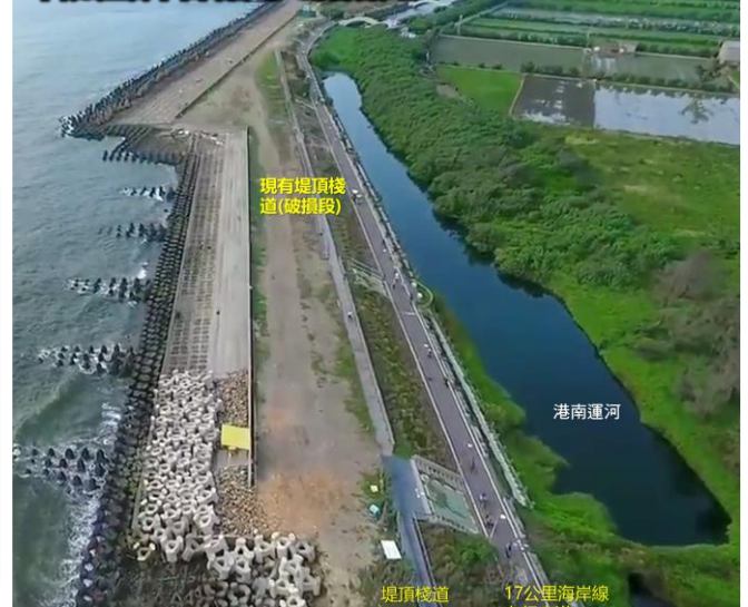
中段堤頂平台現況多為裸露地
