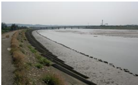
鳳山溪北岸堤防（崇義里）
