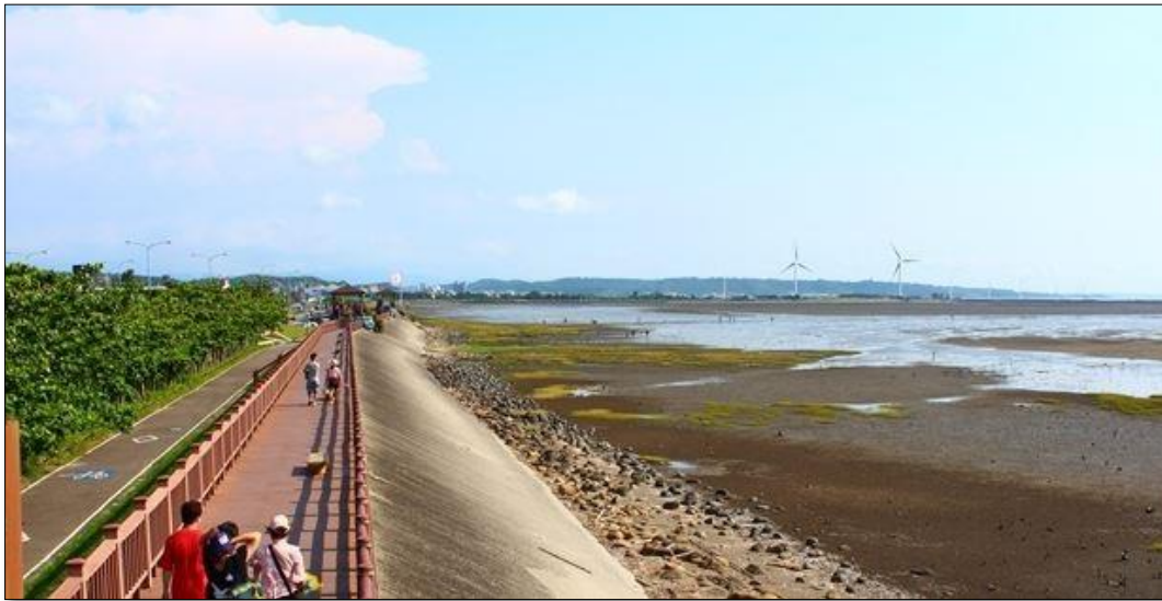
圖 4-18 堤岸與木棧道共構示意照片
