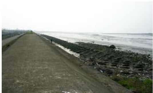
鳳山溪南岸堤防（新港里）
