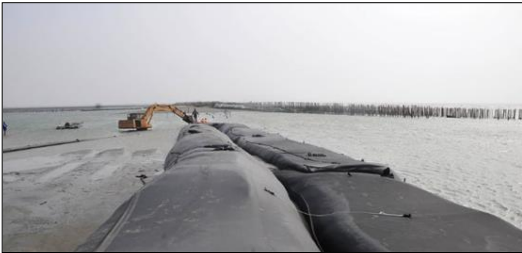
圖 4-19 地工沙腸袋工法示意照片
