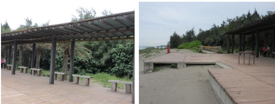
圖 4-2-16 新月沙灣入口既有涼亭木棧道現況
