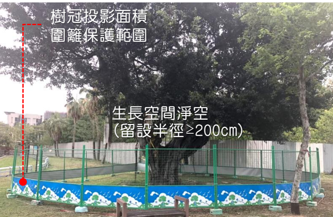
▲受保護樹木(計5株)施工期間保護措施
