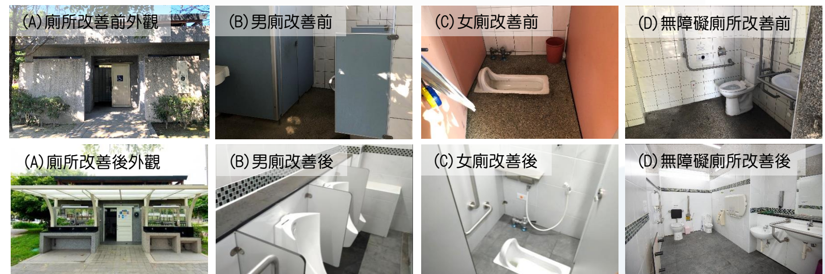
▲公廁改善：洗手台移到戶外，避免室內容易濕滑，並增加透光遮雨棚。更新既有公廁老舊內裝及設施，建置無障礙親子廁所、扶手、求救鈴等服務設施，提供更安全、舒適的如廁環境。
