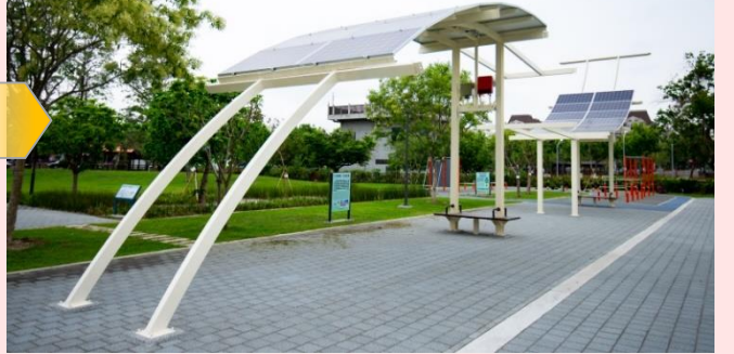
2021公93水環境教育園區 太陽能光電棚架
