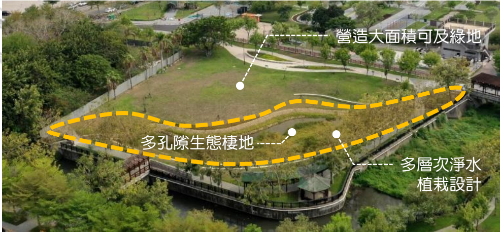
▲本案改造後的滯洪空間
