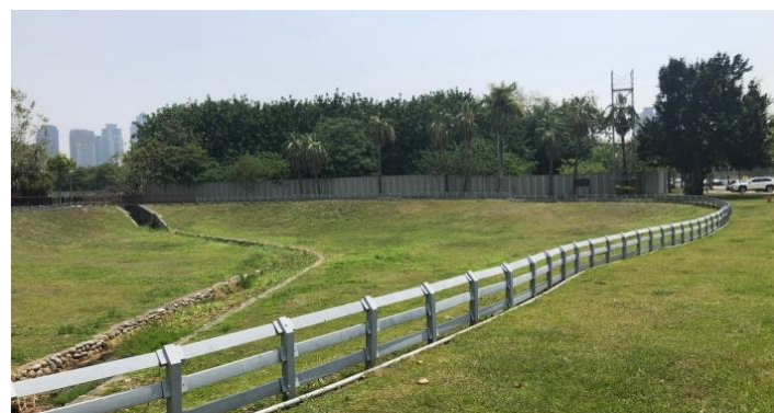
③ 滯洪池原況缺乏生機
