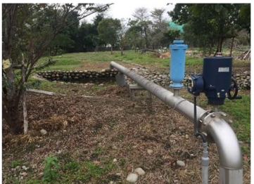
現況砌石水道放流管。
