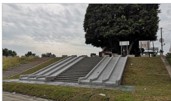
園區部分區域已由西螺鎮公所改善
