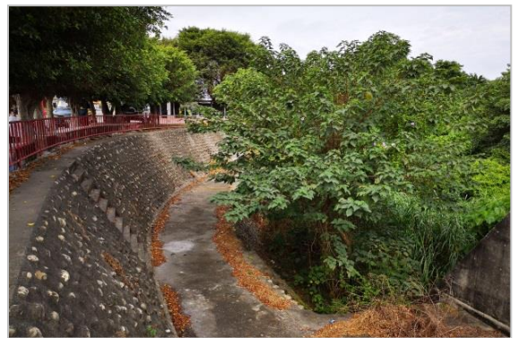
引西圳舊圳道現已荒廢閒置
