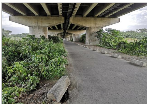
溪州大橋橋下道路可作為環狀動線
