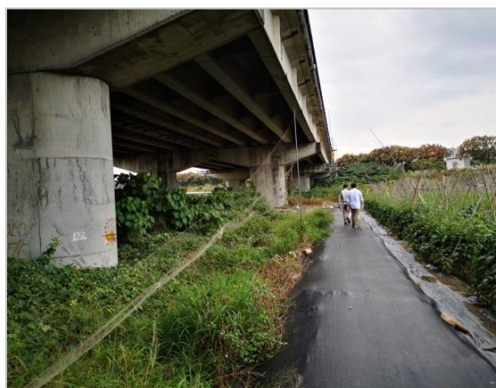
溪州大橋橋下空間陰暗雜亂
