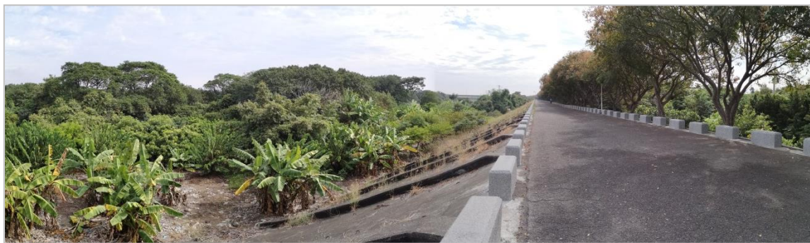
堤防道路旁的引西圳舊圳道被私人農地佔用
