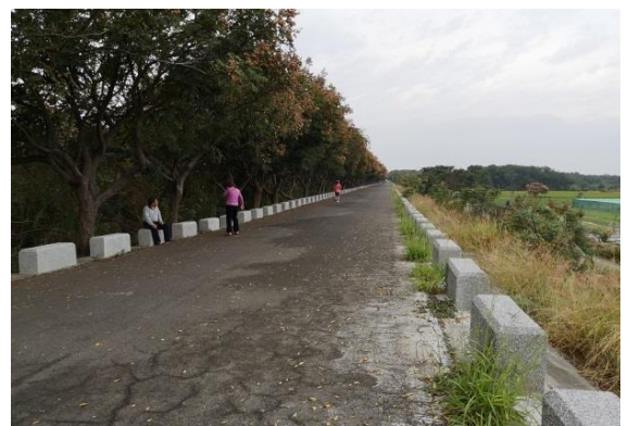
堤防道路為在地人日常運動的動線
