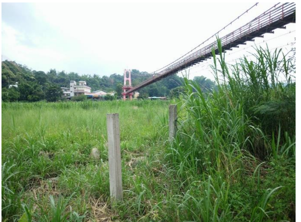
水岸及護坡照片
