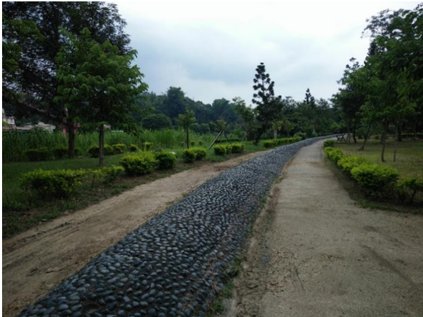
工程設施照片（親水公園步道）
