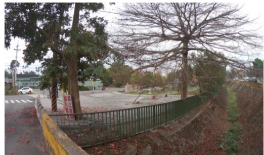
堤後排水路現況
