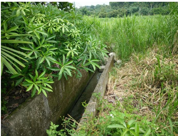
水岸及護坡照片
