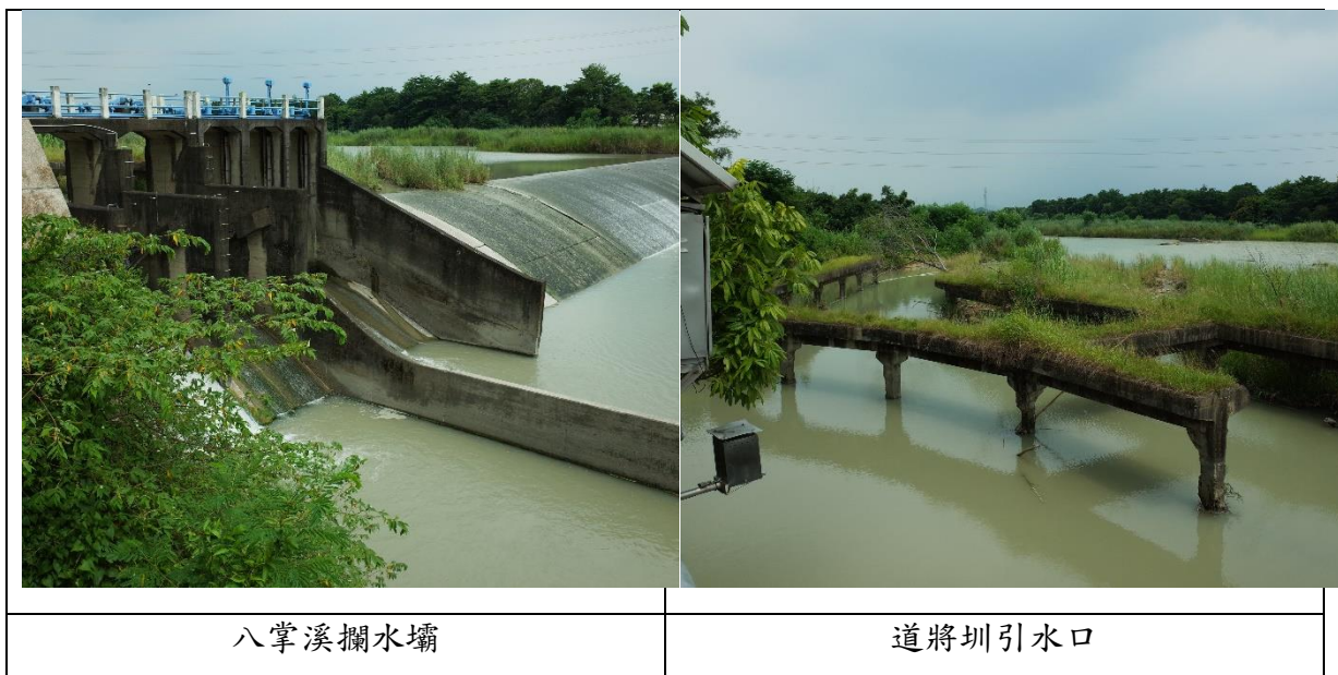
圖 2-3 道將圳引水口周邊景觀設施
