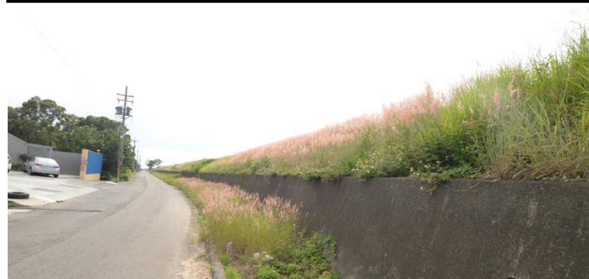
6.防堤隔絕陸地與溪岸之間的視野
