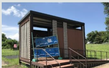
2. 既有廁所因缺乏水源無法提供遊客使用
