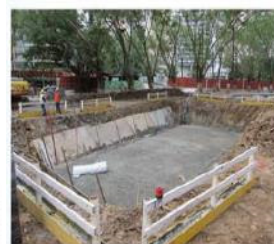
基礎打底整平
