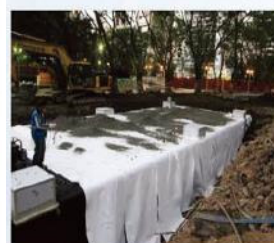
完成後回填覆土
