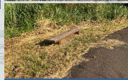
3. 園區內既有設施損壞—休憩座椅
