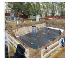
不透水層鋪設
