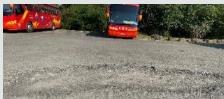
1. 第一停車場地埤損壞嚴重，雨後易積水造成環境髒亂
