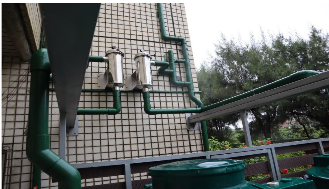
範例：初期雨水過濾器-濾石濾網式(桃園觀音工業區)
