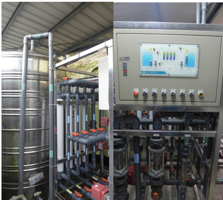
範例：雨水貯集管線旁通迴路及控制器(桃園高義國小)
