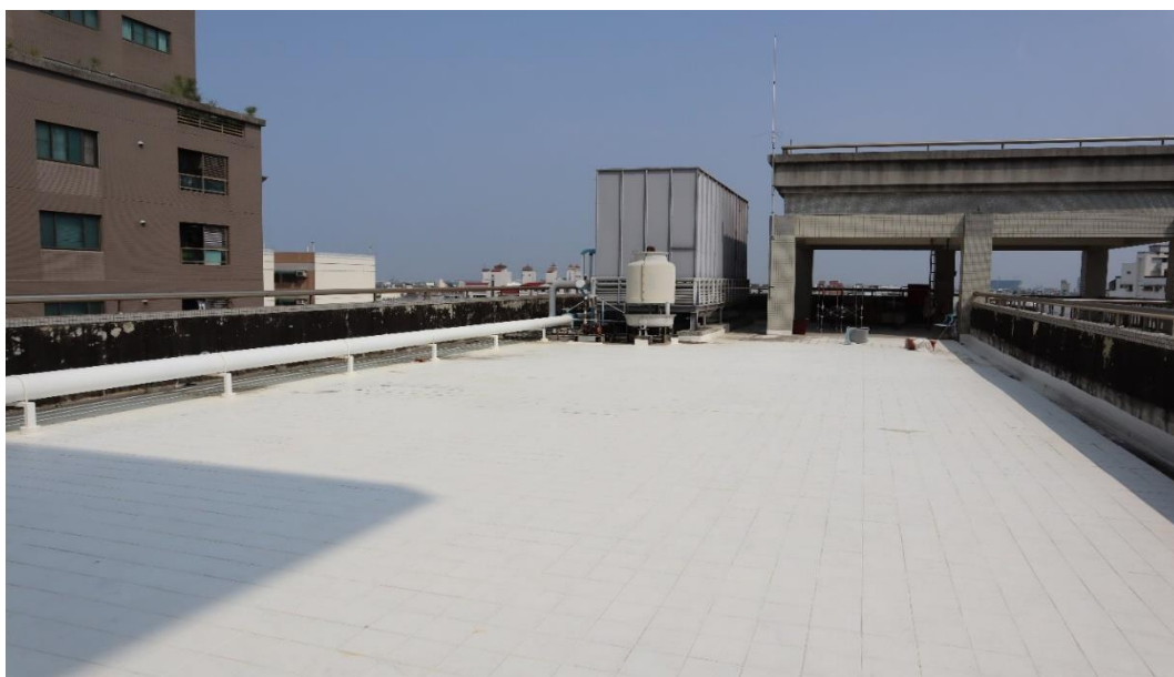
範例：平屋頂型式(台南市政府消防局-永華辦公室)
