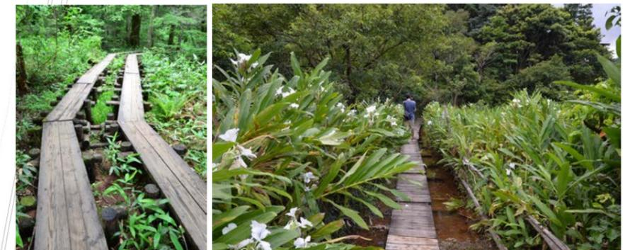
泥灘地步道以簡易、耐水淹(架高型棧道或固化土)之原則規劃
