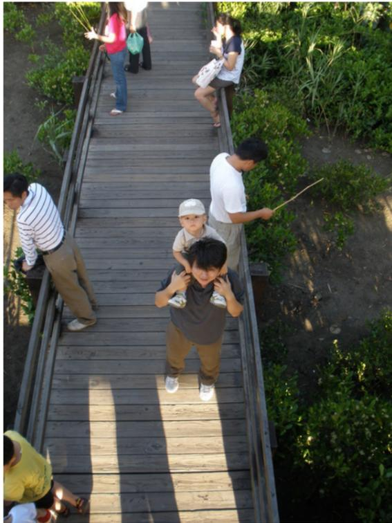
依開放性、深度觀察區環境生態體驗及人潮量之不同，分別規劃不同規格之棧道寬度。並考量周邊地勢、紅樹林分布/生長高度等狀況，評估欄杆設置之必要性及高度，以拉近與自然生態的接觸。
