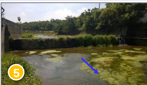
0K+427大型 固床工 現況老舊，植生茂盛
