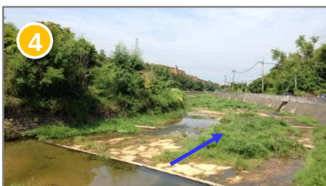
0K+274固床工下游渠道現況植生茂密，雜草叢生
