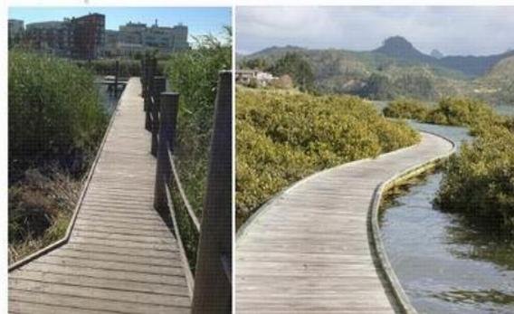
考量低干擾減量原則，評估棧道寬度及單邊欄杆、護欄方式施作
