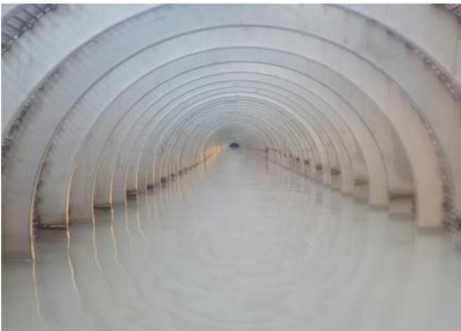
圖 1 溪埔伏流水集水管
