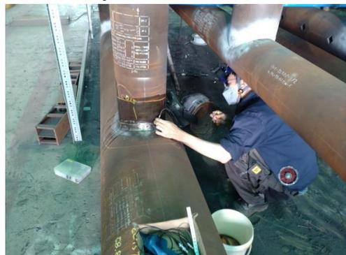
圖 2、靠船鋼管節點陣列超音波檢測
