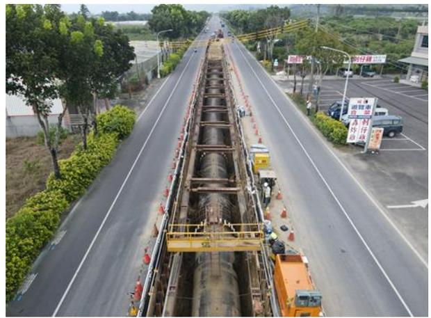
圖 2 曾文南化聯通管-明挖段管材埋設
