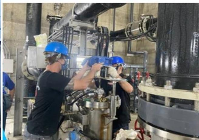
圖 2 自清過濾器滲漏保修作業
