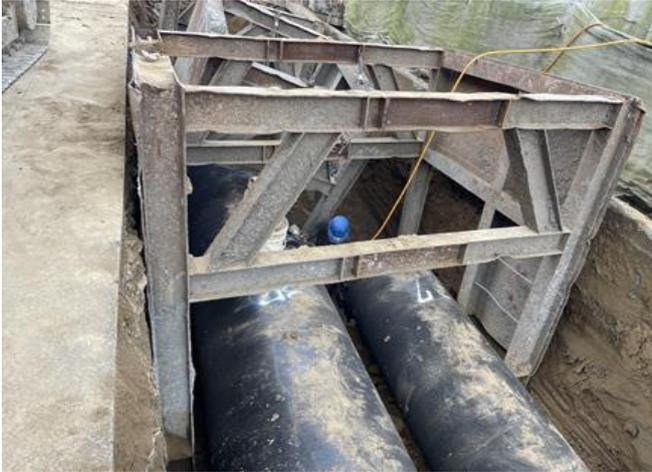
圖 1 送水管線施工
