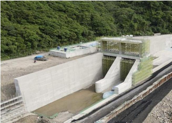
圖 1 引水路制水閘段結構體
