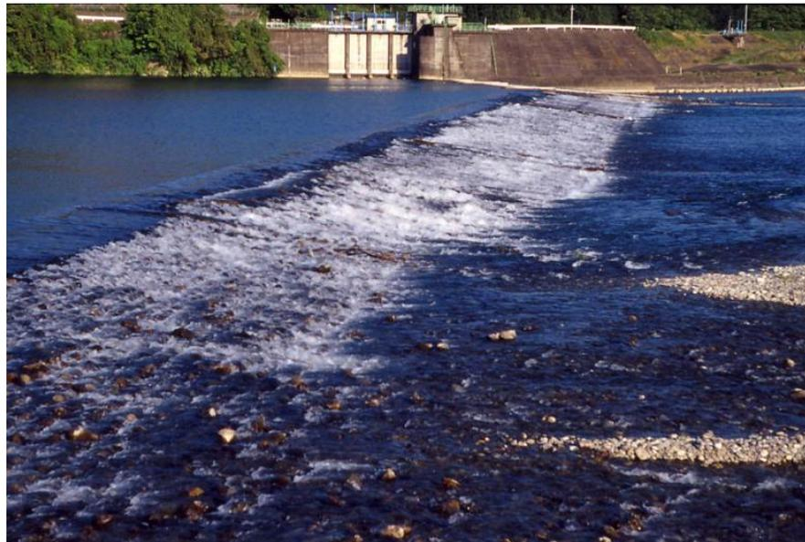
圖 5-14 八田堰之堰體設計相當於全斷面魚道
