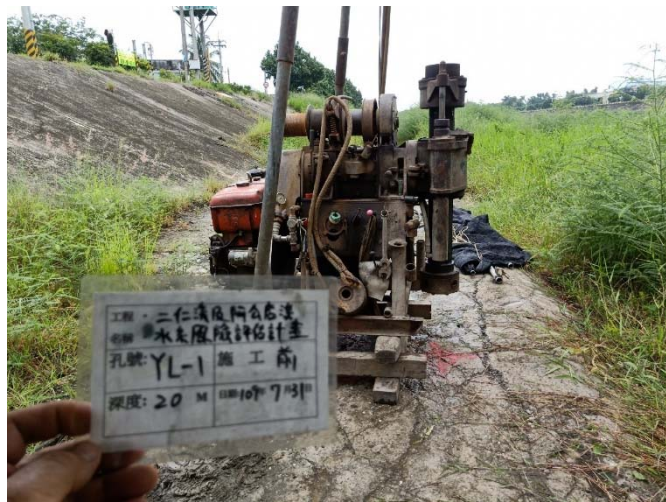
YL-1 鑽孔(施工前)
