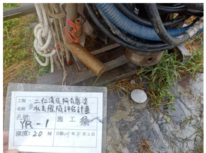
YR-1 鑽孔(施工後)
