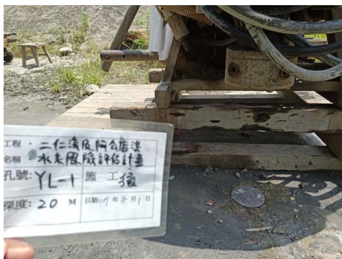
YL-1 鑽孔(施工後)
