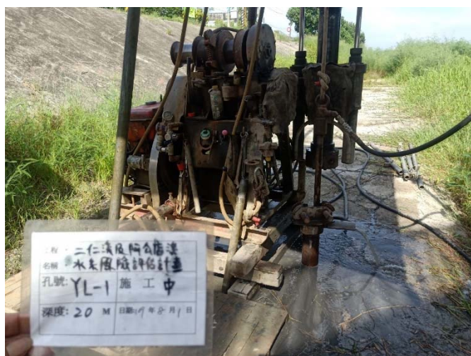
YL-1 鑽孔(施工中)
