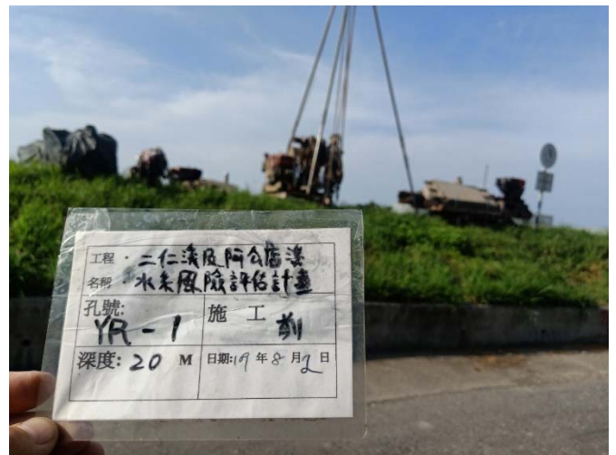
YR-1 鑽孔(施工前)
