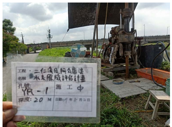
YR-1 鑽孔(施工中)
