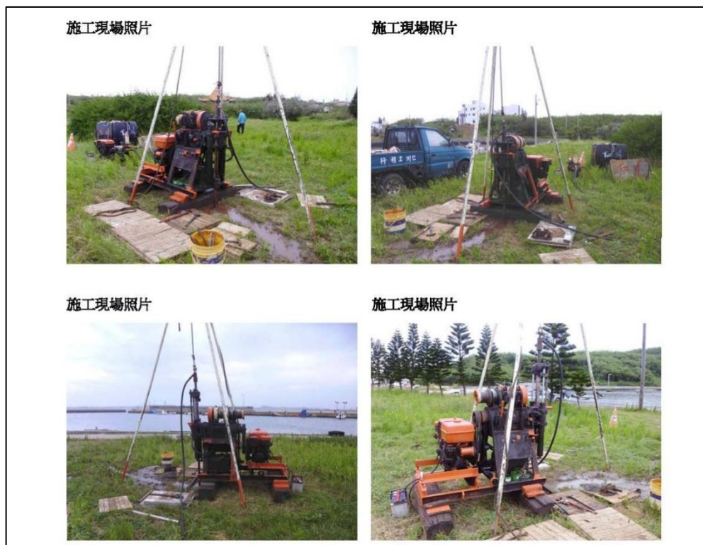
圖 3-13 鑽探施工照片
