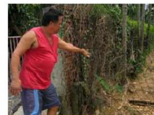
聖帕颱風中林村道路側坡土石沖刷及指出淹水高度
