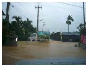
813豪雨中林村道路淹水並挾帶泥土(2)
