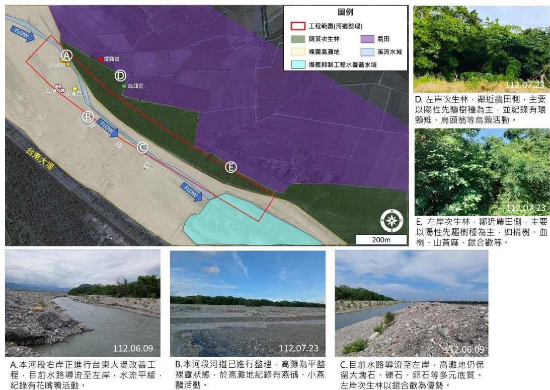
圖 1-1 河道整理工區棲地現況
