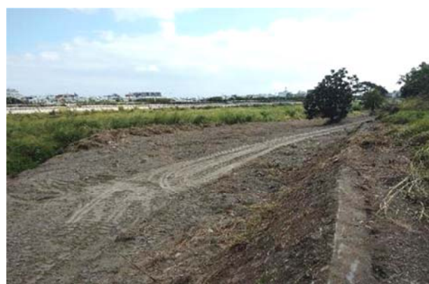
說明：工地現況
