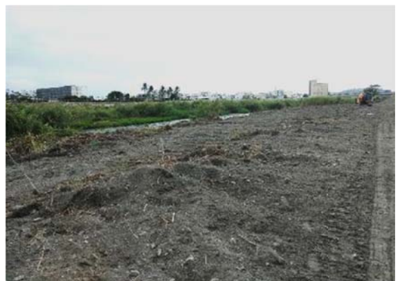
說明：工地現況
