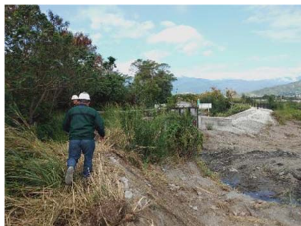
說明：工地現況
